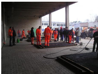
Einbau von FÜAS an drei unterschiedlichen Modellen während einer GüFA-Schulung
