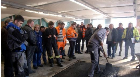
Einbau von FÜAS zu Schulungszwecken
